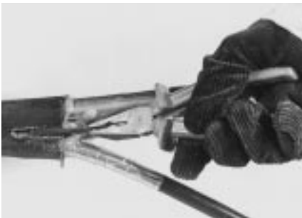
4 Нагрейте зону разветвительного зажима и удалите его плоскогубцами.
