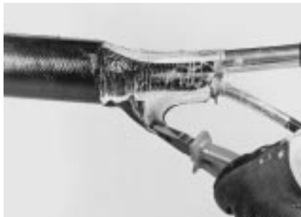
5 Удалите конец муфты плоскогубцами, осторожно стягивая его с кабелей. При необходимости дополнительно прогрейте.
