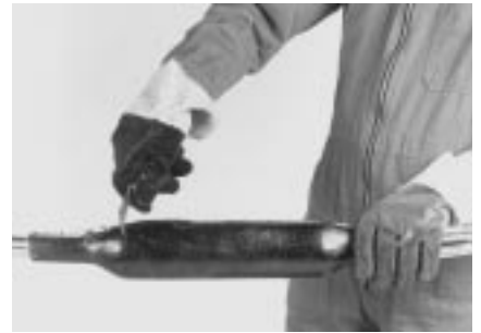
3 Прогрейте муфту по окружности и надрежьте, как показано на рисунке.
