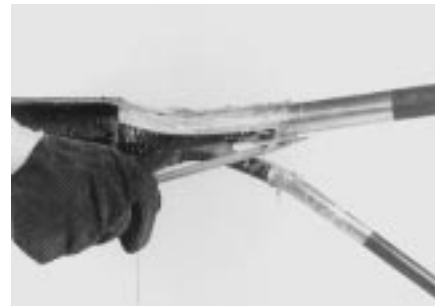
6 Пока клей горячий, разделите кабели соответствующим инструментом (отверткой), чтобы легче было вставлять разветвительный зажим при монтаже новой муфты.
