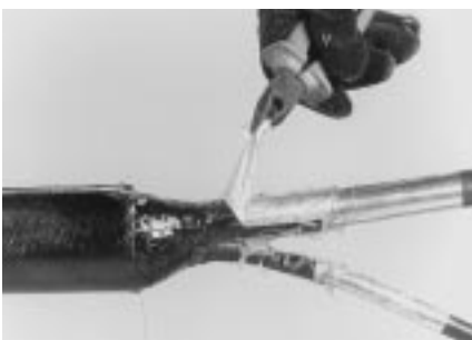
7 плоскогубцами удалите с кабеля алюминиевую пленку перекрывающего клапана. При необходимости немного прогрейте.
